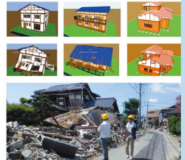
▶家屋倒壊シミュレーションと倒壊家屋現地調査(熊本県益城町)
